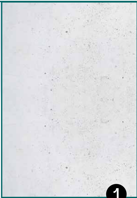
beton panelen gevel
